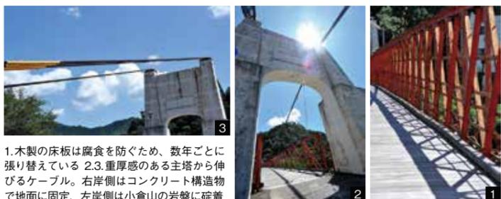
1.木製の床板は腐食を防ぐため、数年ごとに張り替えている 2.3.重厚感のある主塔から伸びるケーブル。右岸側はコンクリート構造物で地面に固定、左岸側は小倉山の岩盤に碇着
