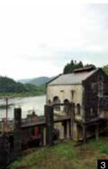
3.4.5.大正6年に完成した放水口発電所。本館発電所の放水口から出た水を再利用して発電。新型水車開発能力のなかった時代に、既存の水車を連成して能力を高めた。本館とこの発電所は、親子のように寄り添って立つ ※放水口発電所は現在、立ち入りできません
