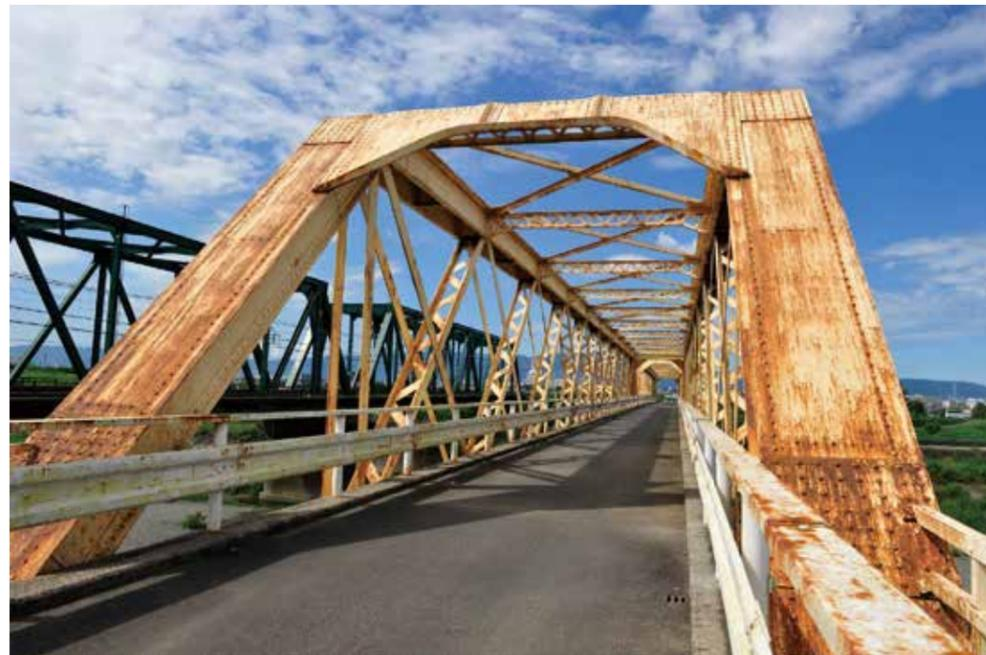
平面的で武骨な印象の橋脚。橋の構造は格子形に斜材が続くダブルワーレントラス。鉄材には19～20世紀に主流だった錬鉄が用いられている。すぐ隣に架かる東海道本線の橋梁と比べると、旧揖斐川橋梁の高さは鉄道が走っていたとは思えないほど低い
