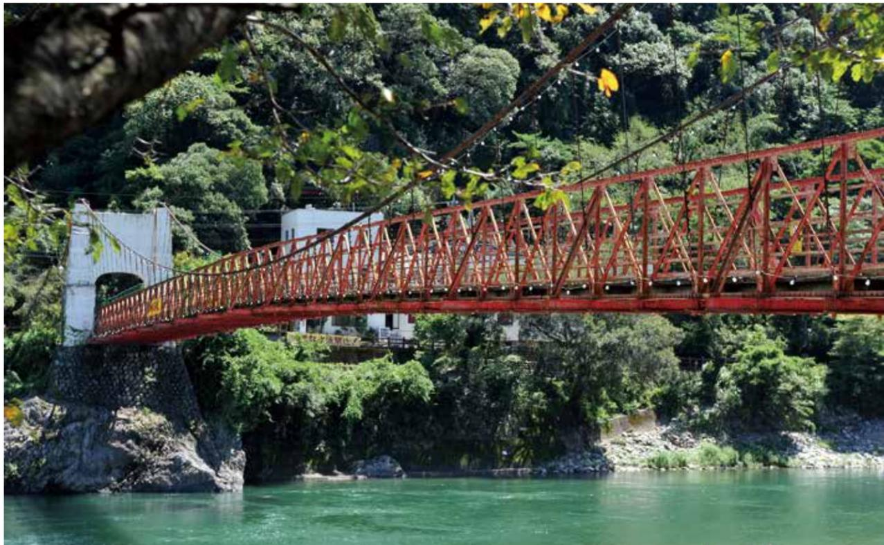
美濃市街地の北部、かつて船着き場のあった小倉山の麓に建設された。滔々と長良川が流れる風景に、ゆるやかに湾曲する赤い吊り橋が映える。桁部分は交差した鋼材の上に丸太を渡し、その上に平板を固定。風が吹いてもびくともしない強靱な造りで、昭和40年代までは荷馬車や自動車も走っていた。現在は保全のため、同時に橋を渡るのは20人までとしている
